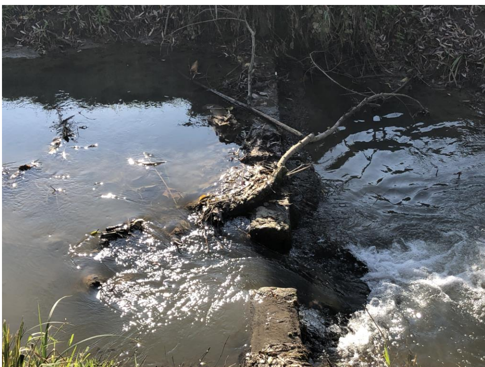
6B – Detriti e depositi vegetali su briglia nel Colatore Serio Morto.
